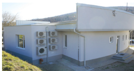
Novi nadzorni center v Cepkih.
